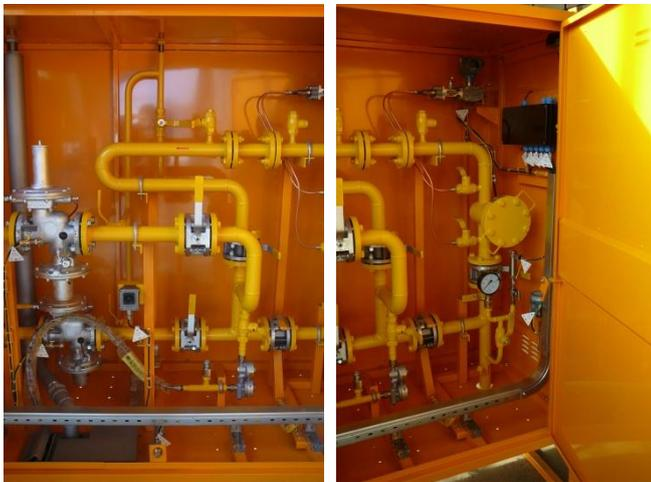
На фото: ПРДГ на базе двух РДК-50Н с узлом учета и комплексом телеметрии
